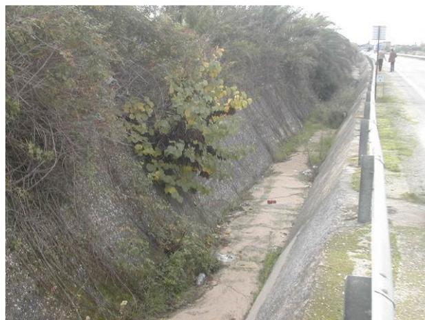
Foto.5 Canalizzazione Cava del Bosco: secondo marcato restringimento e cambio sezione
