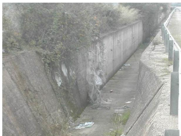
Foto.6 Canalizzazione Cava del Bosco: terzo marcato restringimento e cambio sezione
