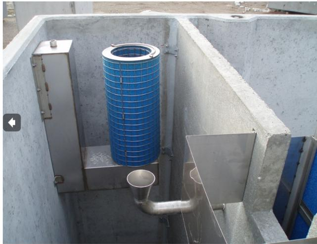
Fig.15 Comparto di disoleatura con in evidenza il filtro a coalescenza
